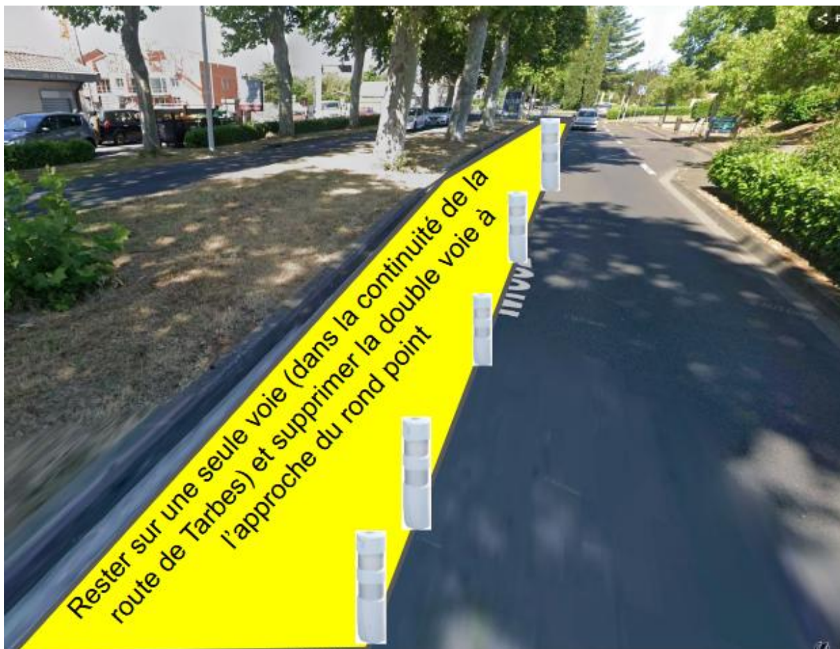
Réduction de voie tactique entrée giratoire Sud-Ouest
