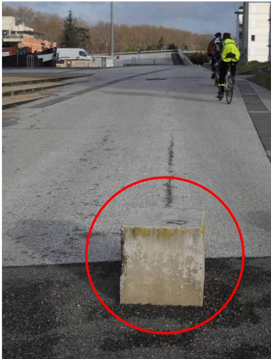
Bornes béton devant le port technique. Si l'espacement permet le passage de tout type de vélo, leur présence est extrêmement dangereuses (angles, couleur).
