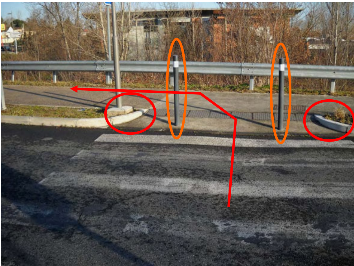
Traversée de l'avenue de l'Agrobiopole. Trajectoire à angles aigües difficile, poteaux métalliques (en bord de piste cette fois-ci) et 2 voies de circulation à traverser. Seule la partie centrale est utilisable en raison de rebords de trottoirs saillants. Carrefour dangereux et impraticable pour tout autre vélo que vélo de ville et VTT.
