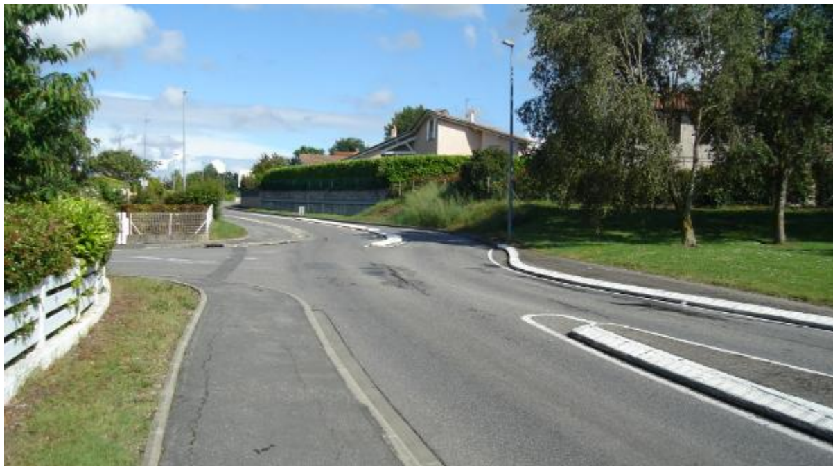
Pas de trottoir à droite + chicane
