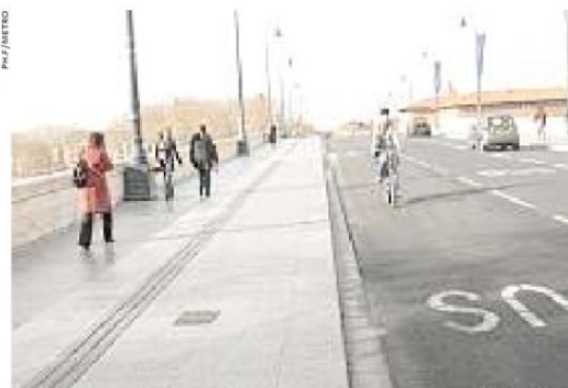
Le pont Neuf est aménagé après plusieurs mois de travaux.
